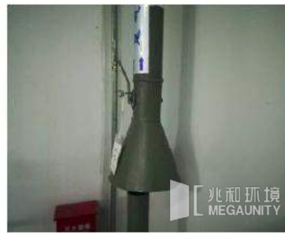
下卸料离心机母液罐尾气
